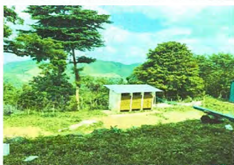
Foto 5: Sustitucion de cubierta de laminas
