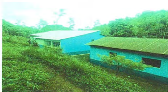
Foto1: Cubierta de laminas nuevas
