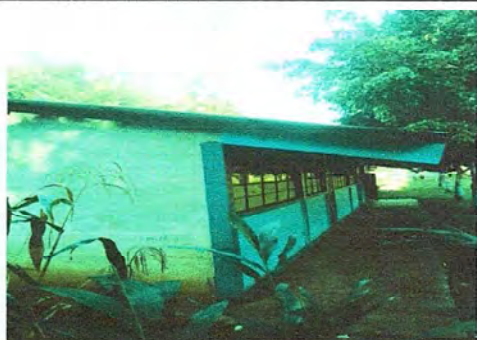
Foto 3: Mantenimiento de piso
